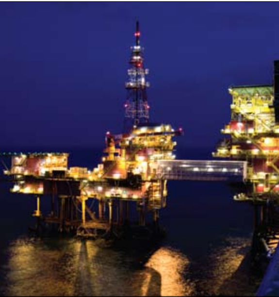
Gas productieplatform K-14 Complex
