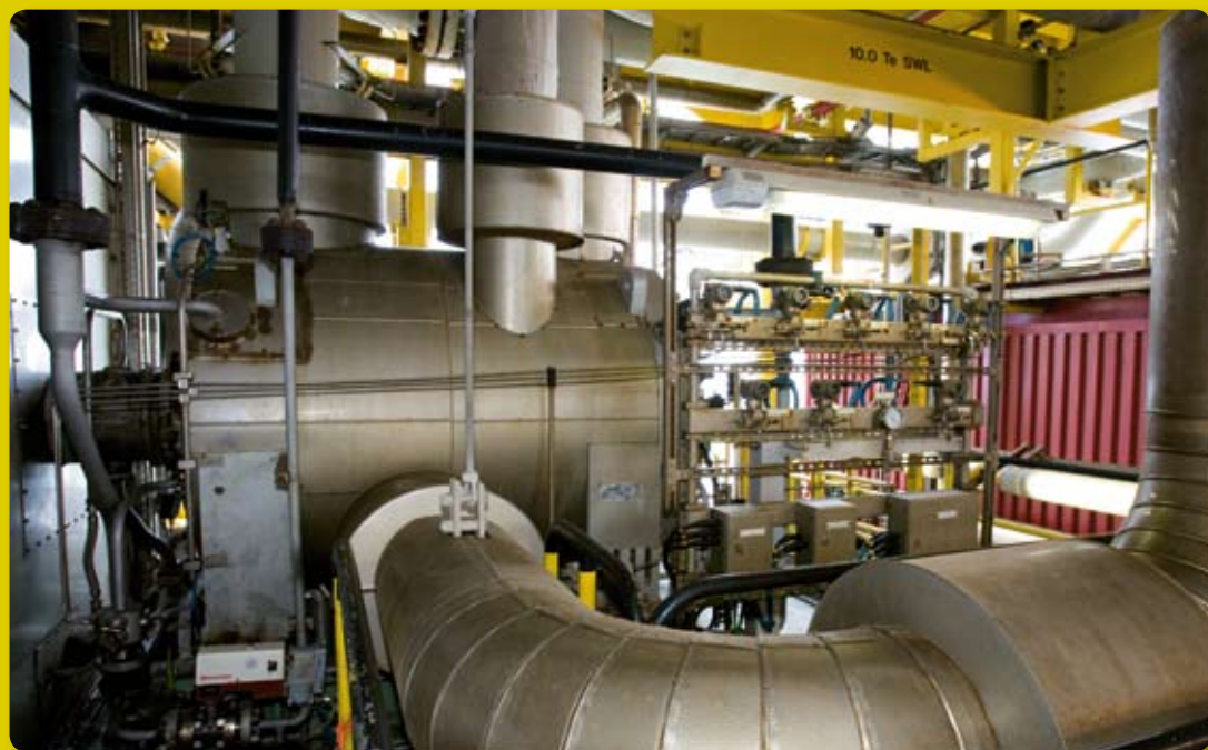
↑ Twee gigantische compressors persen het gas samen totdat het een druk van zestig bar bedreikt. Deze hoge druk is noodzakelijk om het gas naar de wal te sturen en daarna verder naar woningen en bedrijven in heel Nederland.
