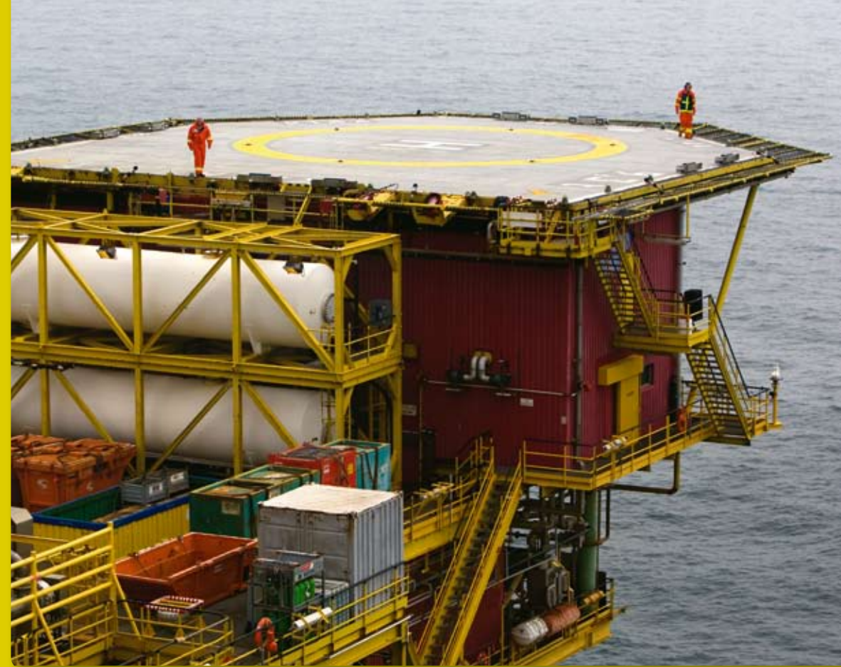
↑ De HLO's ( helicopter landing officers ) inspecteren het helidek, voordat een nieuwe bemanning arriveert. Het dek heeft een middellijn van tweeëntwintig meter, de diameter van de landingscirkel is elf meter. Precisievliegen dus...
